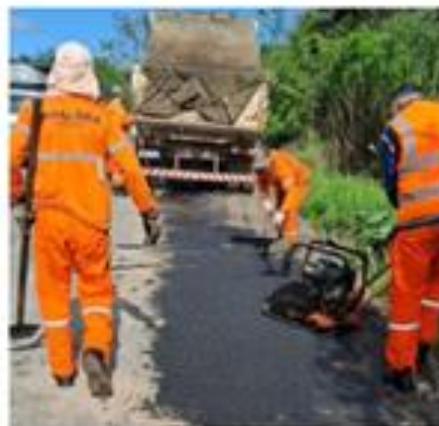
RS-118 está passando por obras de melhoria em diferentes pontos da rodovia.
